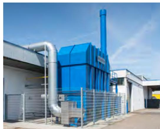
Schadstoffe wie Lösemitteldämpfe aus dem Flexodruck neutralisieren wir effizient und umweltverträglich durch eine eigene Nachverbrennungsanlage
